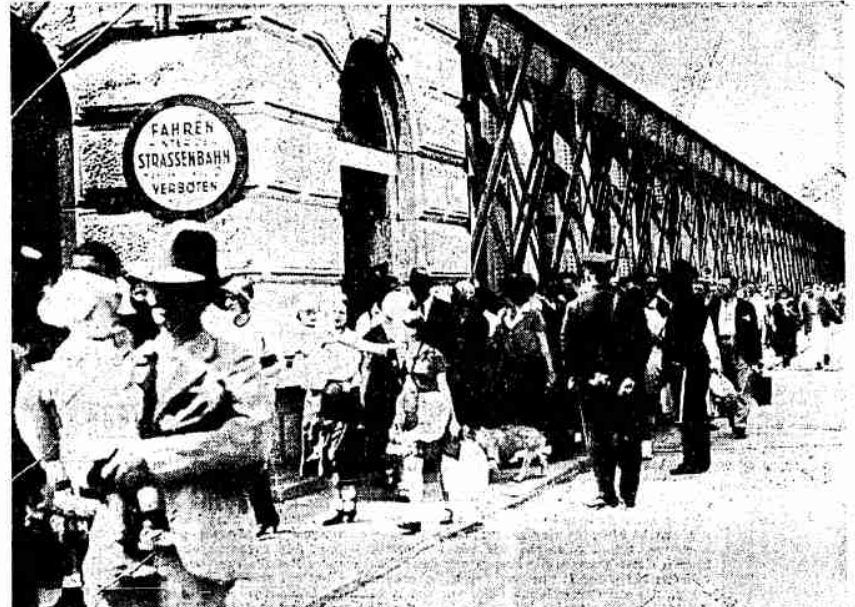
Über die alte Reichsbrücke durften zuletzt nur noch Fußgänger – sie war einsturzgefährdet
