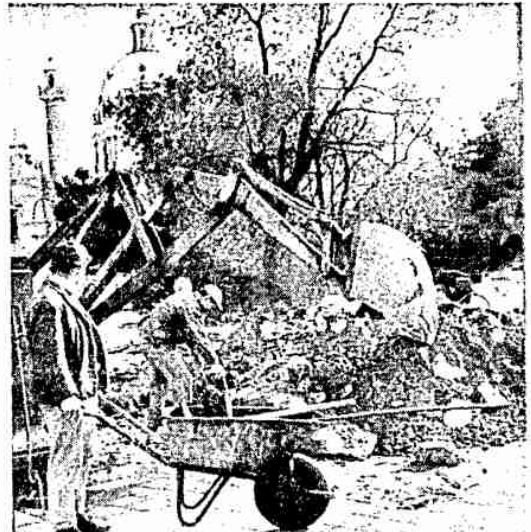
Schubraupen und Bagger haben vor der Karlskirche ihr Werk begonnen
