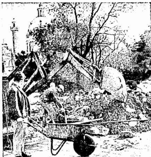
Schubraupen und Bagger haben vor der Karlskirche ihr Werk begonnen
