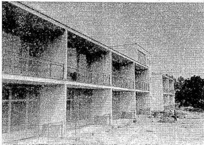
Eine Wand des neuen Schulhauses in der Franklinstraße ist durchsichtig; die Glasflächen können im Sommer geöffnet werden, so daß Lehrer und Schüler wie im Freien sitzen
