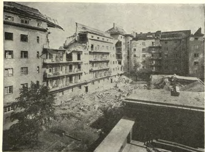
Der städtische Domes-Hof am Margaretengürtel nach einem Luftangriff. In den städtischen Wohnhäusern wurden 18.127 Wohnungen beschädigt, darunter 3.877 zerstört, 5.129 schwer und 9.121 leicht beschädigt.
