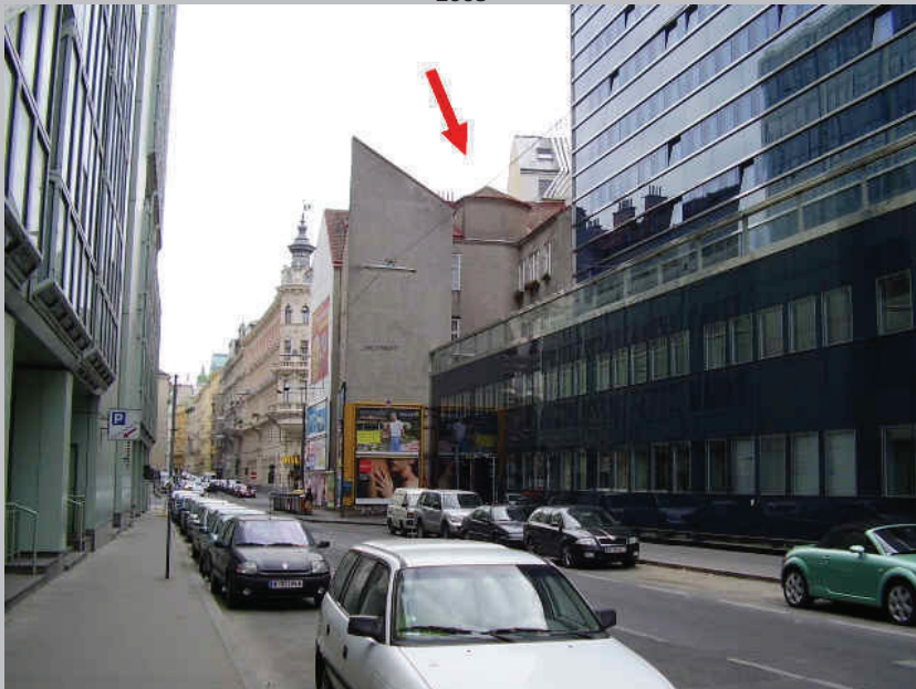
Unten: Entgegengesetzter Blickwinkel von der Wiedner Hauptstraße, zu der vom Freihausinnenhof durchgebrochen wurde - daher die bis heute kahle Fassade
