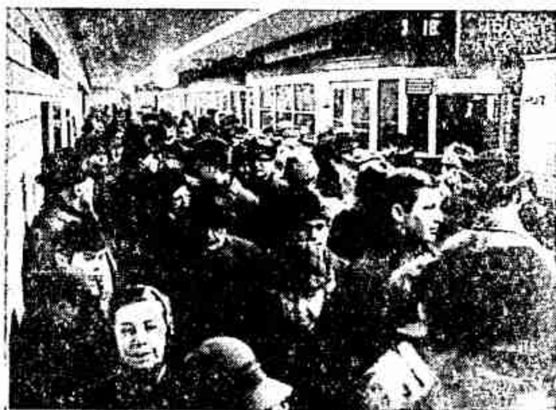
In den Straßenbahnstationen unter der Erde warteten tausende Festgäste auf den festlich geschmückten Eröffnungszug der unterirdischen Strecke
