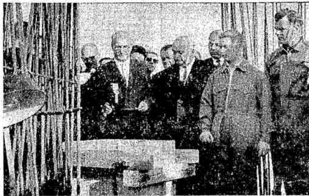
EIN WALD VON STAHLSTANGEN wird den Betonkörper des Turmes tragen
