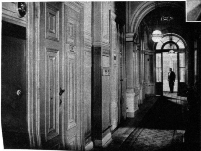
Dieses Bild zeigt den Korridor des Hotel Imperial, in dem man am 25. Juli, am Tage des Putzsches, den Hauptanstoß der unseligen Ereignisse dieses Tages, Dr. Rudolf Weydenhammer, sah. In Zimmer Nummer 19 wohnte Gesandter Dr. Hintelen, der jetzt in Wien im Mittelpunkt des sensationellen Prozesses steht, in Zimmer Nummer 17 Präsident Reitlinger, der Dr. Weydenhammer gesehen hat. Im Hintergrunde Zimmerkellner Hans Gruber, der Dr. Hintelen bediente.
